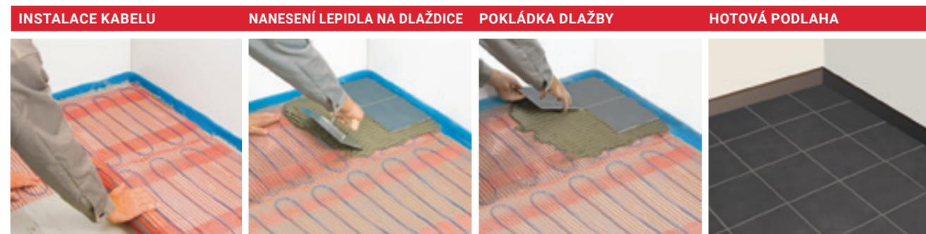
Před pokládkou rohože nejprve pečlivě očistěte povrch podkladu. Rozviňte rohož a položte na podklad lepicí stranou. V případě snížené kvality povrchu a s tím spojené horší přilnavosti, zajistěte topnou rohož přídatnými fixačními prvky.
