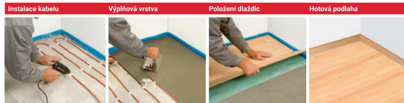
Kabel důkladně připevněte k čisté a odmaštěné podlaze. Položení můžete realizovat do předem vyfrézovaných drážek nebo pomocí tavného lepidla, event. fixačních pásků.
