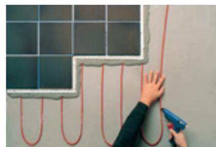
T2Red je samoregulační podlahový topný kabel pro sníženou instalační výšku. Kabel je možno instalovat pod všechny typy podlahových krytin bez nebezpečí přehřátí. Inteligentní topný kabel je ideální při zvyšování komfortu bydlení v celém domě, od koupelny až po dětský pokoj.
