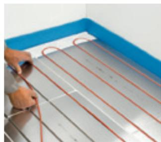
Do drážek vložte topný kabel T2Red. Požadovaný topný výkon je závislý na rozteči kabelu.
