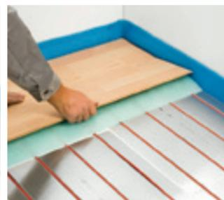
Na desky Reflecta položte podložku pod dřevěné podlahy (kročejovou izolaci) a pak položte novou dřevěnou nebo laminátovou podlahu podle pokynů výrobce.
