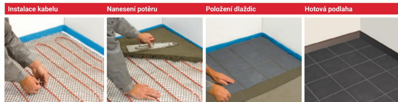
Před začátkem instalace topného kabelu určete umístění topných zón. Kabel je nutné důkladně připevnit k podkladu a dodržet předepsanou rozteč jednotlivých topných smyček.
